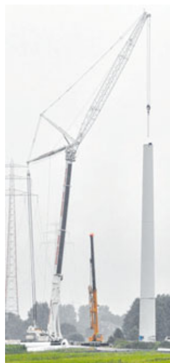
Drei der fünf alten Windräder in Ochsenwerder werden der- zeit abgebaut. Foto: Heyen
