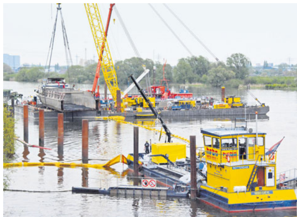
Der geborgene hintere Teil des gesunkenen Binnenschiffes wurde mit dem Schwimmkran auf den Ponton gehoben. Im Vordergrund ist ein weiteres Arbeitsschiff im Einsatz. Foto: Leimig
